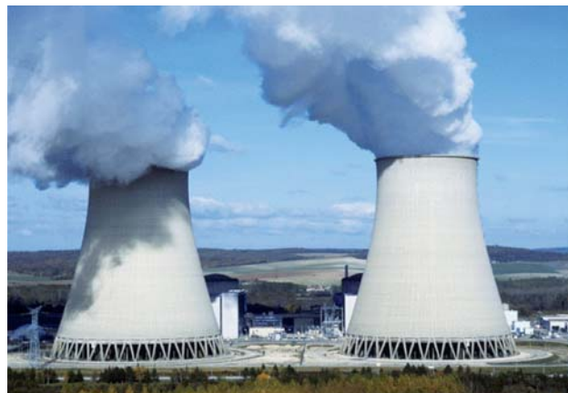
Aéroréfrigérants : Centrale nucléaire de Nogent/Seine.
