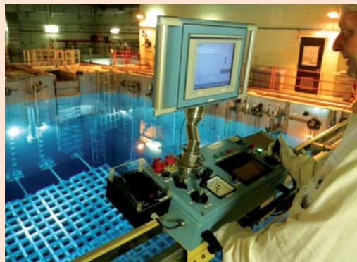
Piscine de désactivation du combustible usé à la centrale de St-Alban. La piscine où le combustible usé séjourne pendant plusieurs années avant d'être évacué à l'usine de retraitement, est équipée d'un circuit de refroidissement et de purification qui lui est propre.
