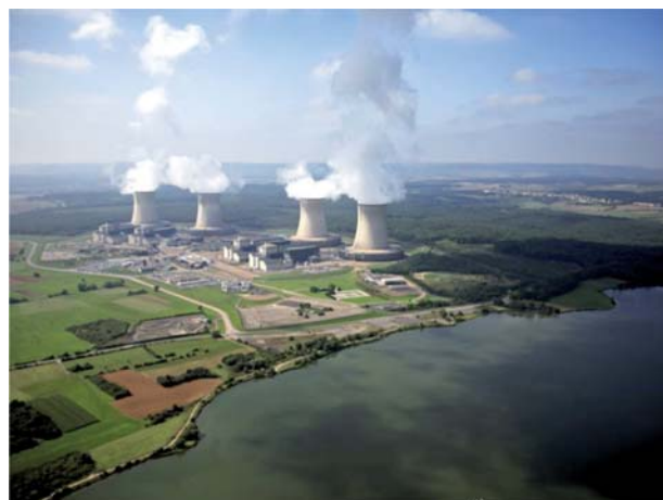
Centrale nucléaire de Cattenom sur la Moselle (4 × 1 300 MWe – 415 ha) et la retenue du Mirgenbach.
