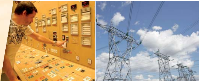
Salle de commande et lignes électriques de la centrale nucléaire de St-Alban sur le Rhône (2 × 1 300 MWe).
