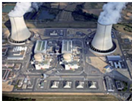
Centrale nucléaire de Civaux (deux unités de 1 450 MWe implantées sur 220 hectares en bord de Vienne).
