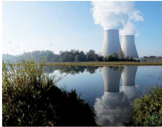
Centrale nucléaire de Belleville sur la Loire (2 × 1300 MWe refroidie en circuit fermé - 165 ha).
