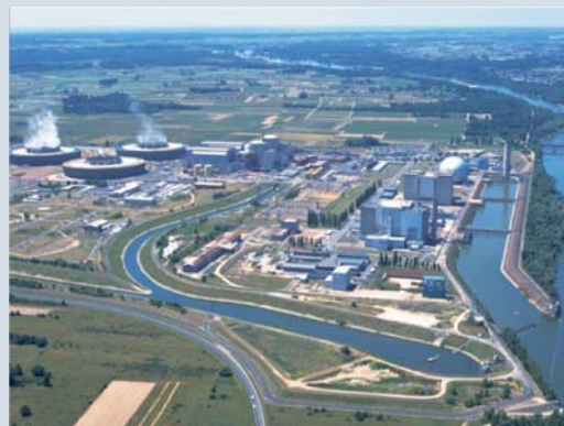
Centrale nucléaire de Chinon (4 x 900 MWe sur la Loire – 115 ha).
