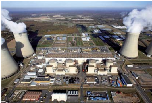
Centrale nucléaire de Dampierre sur la Loire (4 × 900 MWe : 180 ha).
