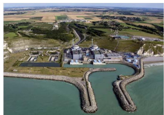
Centrale nucléaire de Penly sur la Manche (2 × 1 300 MWe – 230 ha).
