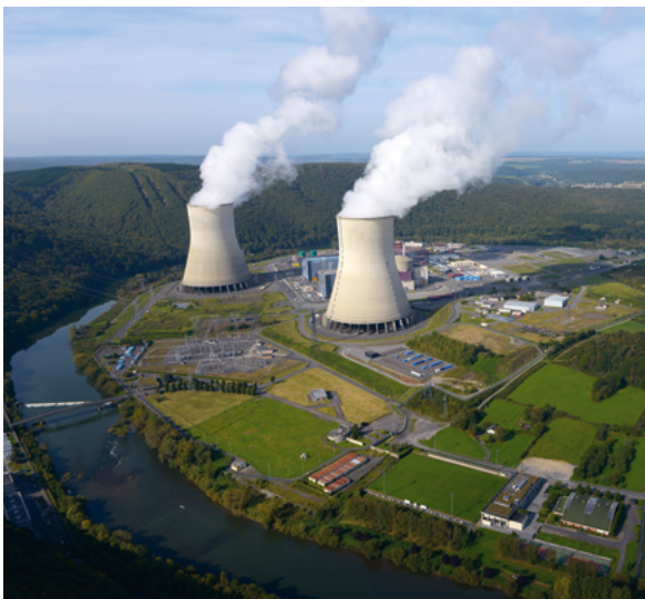
Vue aérienne de la centrale nucléaire de Chooz, située dans une boucle de la vallée de la Meuse, Ardennes © EDF – Jean-Louis Burnod
