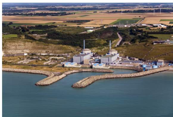
Centrale nucléaire de Penly (2 x 1300 MWe en bord de Manche – 230 ha) © EDF – Didier Marc
