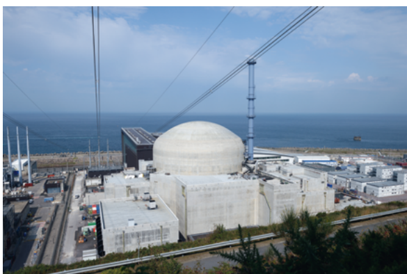
Le chantier EPR Flamanville 3, 27 août 2019 © EDF – Antoine Soubigou
