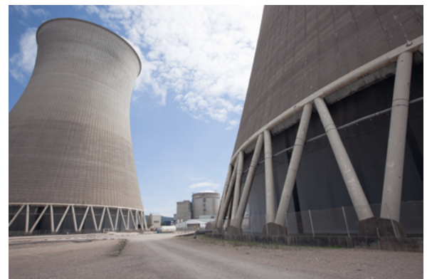
Aэрорéfrigérants de la centrale nucléaire de Bugey. © EDF – Bruno Conty
