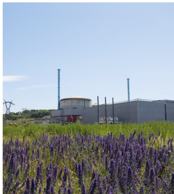
CNPE de Penly (2 × 1300 MWe en bord de Manche) © EDF – Marc Caravéo
