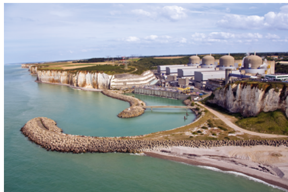
Vue aérienne de la centrale nucléaire de Paluel, en bordure de Manche © EDF – Didier Marc
