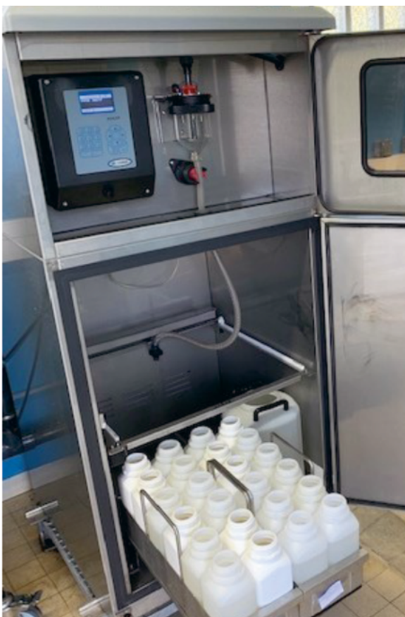
Hydrocollecteur pour les prélèvements d'échantillons à mi-rejet © EDF – Dominique Jourdain
