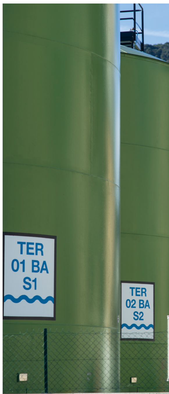
Réservoirs T d'entreposage des effluents radioactifs avant rejet : centrale de Cruas – © EDF – Christel Sasso
