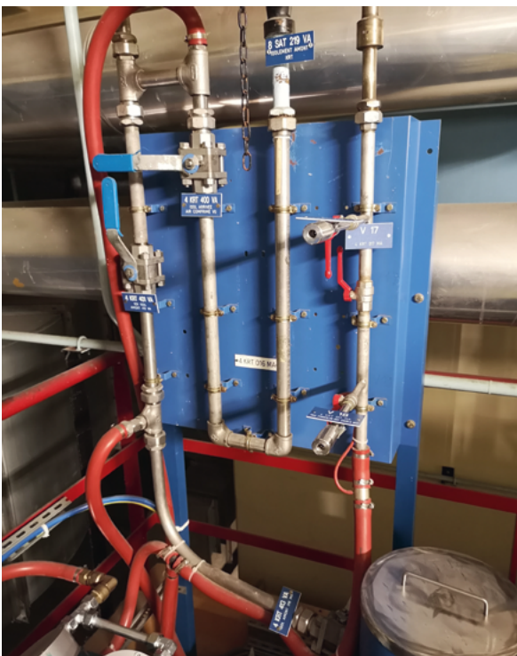
Chaîne de mesure bêta gaz à la cheminée : centrale de Chinon © EDF – Sébastien Draskovic
