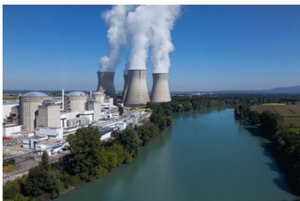
Centrale nucléaire du Bugey sur le Rhône (4 × 900 MWe en bordure du Rhône – 100 ha) © EDF – Matthieu Colin
