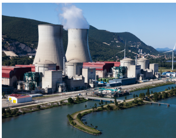
Centrale nucléaire de Cruas Meysses en bord de Rhône, en circuit dit « fermé » © EDF - Matthieu Collin/TOMA
