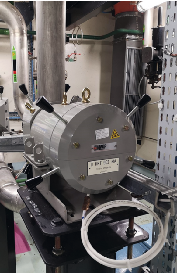
Chaîne de mesure de radioactivité gamma globale sur la canalisation de rejet de Chinon © EDF – Sébastien Draskovic
