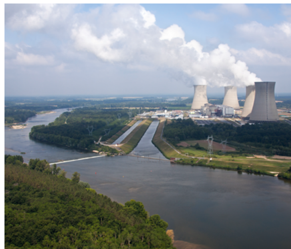
Centrale nucléaire de Dampierre en Burly : la Loire et les aéroréfrigérants en arrière-plan © EDF – Didier Marc
