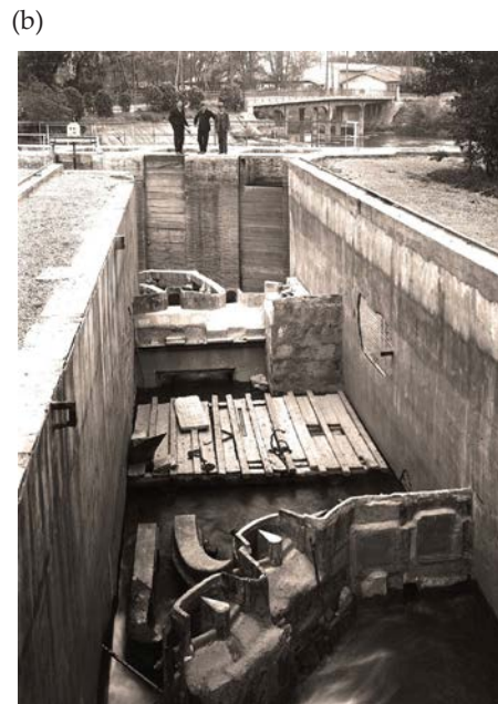
Figure 5.9 Canal courbe investi de modèles réduits d'ouvrages hydrauliques : (a) partie amont couverte vers 1930 ; (b) partie aval avec, à l'arrière-plan, le pont sur la chaussée de Banlève.
