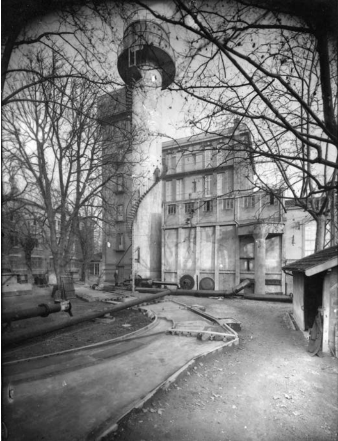
Figure 5.4 Au fond de la cour de l'IET, laboratoire d'hydraulique et son château d'eau alimentant les modèles réduits (1924) ; au premier plan, le modèle de la Garonne à Toulouse. Arch. IMFT, fonds Crausse.
