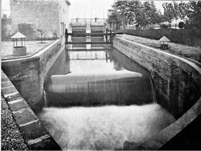
Figure 5.7 Partie amont du canal courbe du laboratoire de Banlève et son déversoir étalon de Bazin. On voit, de part et d'autre du déversoir, les événements prévenant toute dépression sous la lame d'eau déversante.
