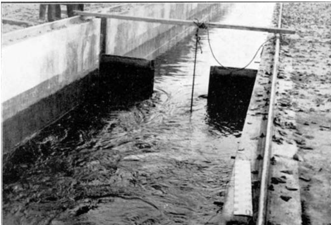
Figure 7.11 Une tige de petit diamètre juste à l'aval d'un élargissement brusque, dans le canal de Banlève, permet d'imposer l'orientation de la veine d'eau vers l'une ou l'autre des parois latérales, levant ainsi l'indétermination de cette orientation (Camichel, 1935a).
