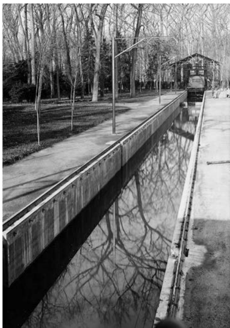
Figure 5.10 Le canal droit mis en service en 1932 ; au fond, le chariot de traction de carènes ; à gauche, le terrain sur lequel sera édifiée la soufflerie. Arch. IMFT.
