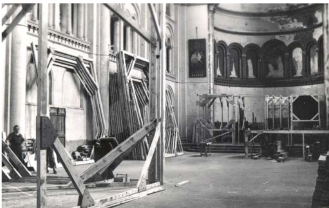
Figure 6.10 Chapelle désaffectée où l'institut de mécanique des fluides de Lille se réinstalle pendant la guerre ; à droite, soufflerie de section octogonale en cours de construction.
