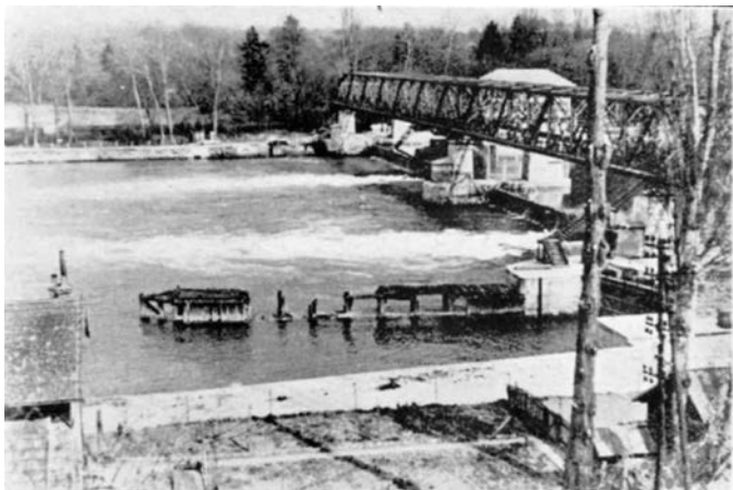
Figure 7.12 Veines convergentes à l'aval du Barrage de Vives-Eaux sur la Seine (Camichel, 1935a).
