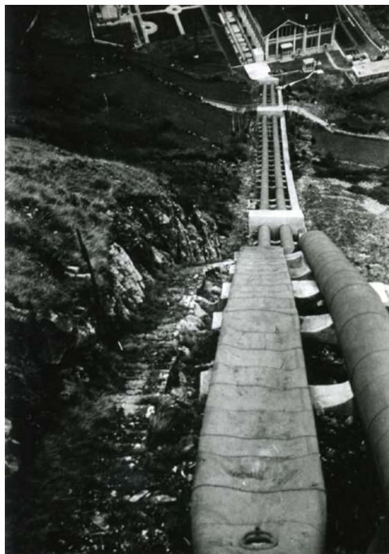
Figure 5.5 Conduite forcée écrasée par une dépression consécutive au dysfonctionnement d'un siphon de prévention des coups de bélier, au-dessus de la centrale du Hourat (vallée d'Ossau), au cours de l'hiver 1928-1929. Arch. IMFT, fonds Crausse.
