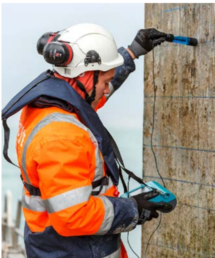
Photo 4/7 : Mesure de potentiel réalisées avec une électrode à barre Cu/CuSO 4 sat (Projet DéCoF-Ré)
