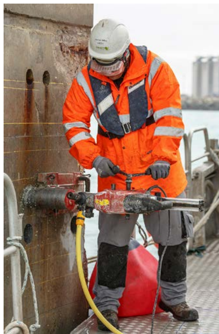
Photo 4/11 : Carottage sur ouvrage (Projet DéCoF-Ré)
