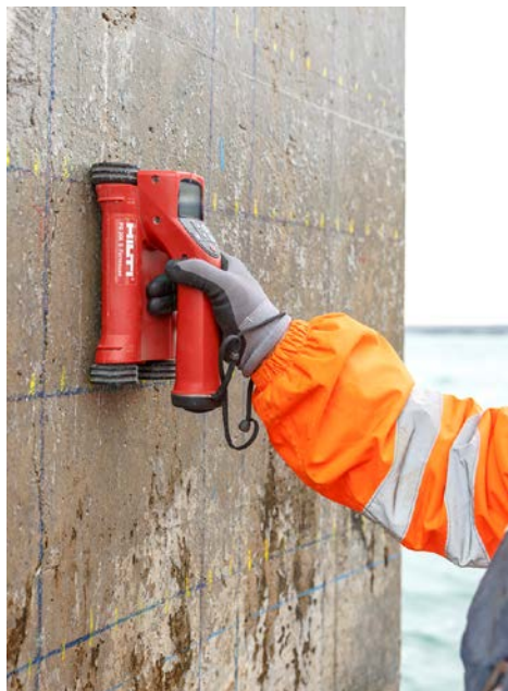
Photo 4/3 : Localisation des armatures à l'aide d'un pachomètre (Projet DéCoF-Ré)
