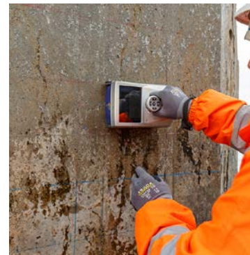
Photo 4/4 : Localisation des armatures à l'aide d'un radar (Projet DéCoF-Ré)
