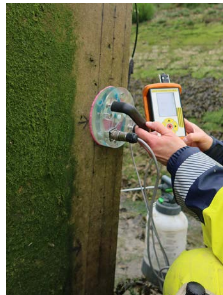
Photo 4/9 : Mesure de la résistance de polarisation de l'armature à l'aide du Gecor10® équipé du capteur "A" (E. Marie-Victoire, LRMH)
