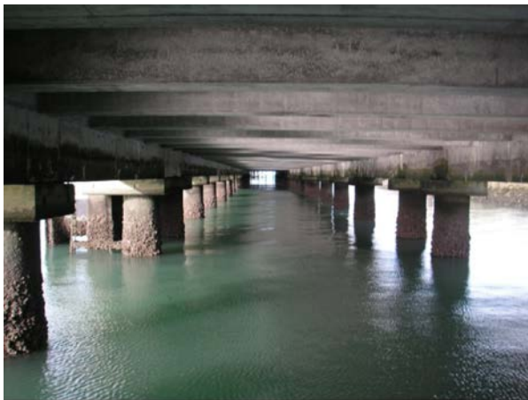
Vue du dessous du quai
