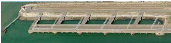
Vue du quai et des passerelles
