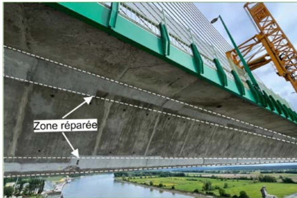
Vue générale d'une zone du pont - âme Ouest
