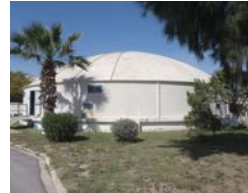
Bâtiment décanteur primaire
