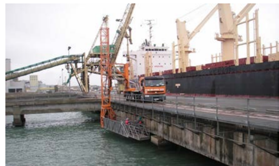
Inspection et auscultation avec passerelle négative
